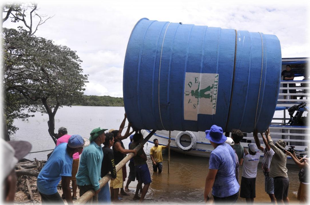
Implantação de 05 novos sistemas de abastecimento de água encanada, com 46.821 metros de rede hidráulica, funcionando com energia solar.
