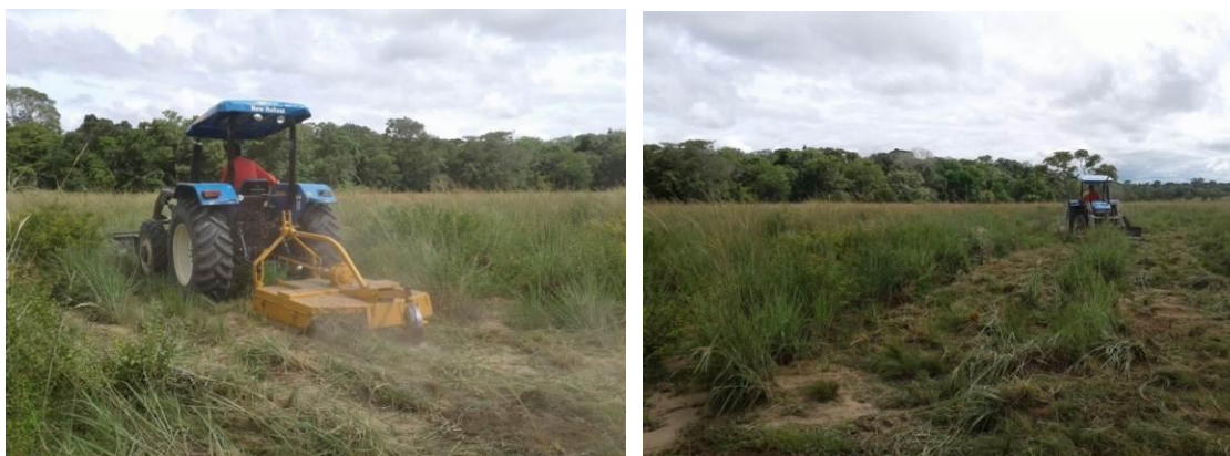
Reparo da unidade demonstrativa de aleias na área do CEFA
