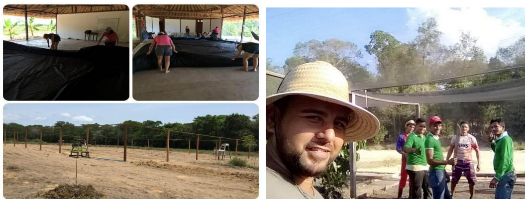
Ampliação/construção do viveiro central do CEFA
