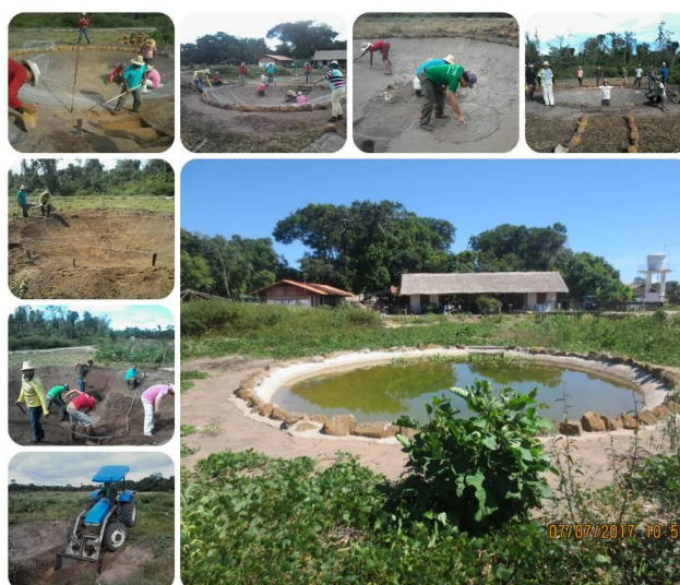
Construção da Mandala Amazônica – CEFA
